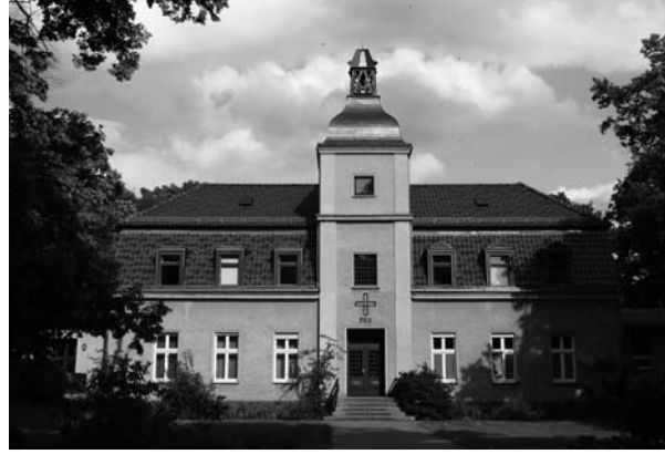
Kloster Alexanderdorf, Hauptgebäude
